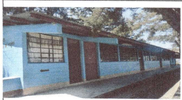
Foto 2: Sustitución de vidrios
