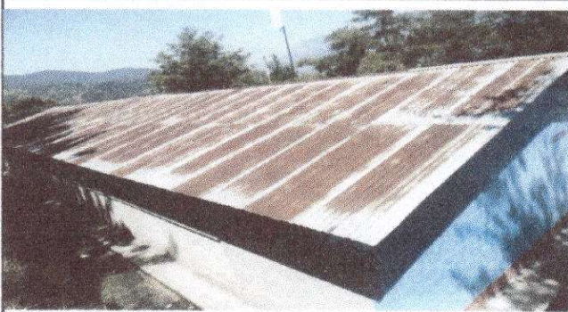
Foto1: Sustitución de lamina
