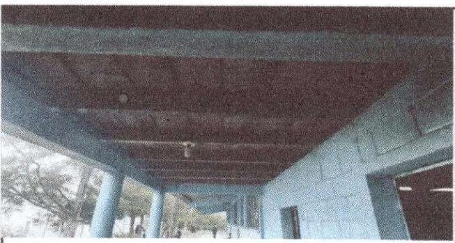
Foto 5: .Sustitución de costaneras
