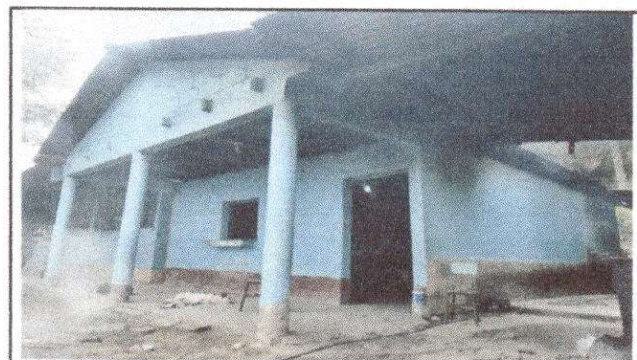
Foto 4: Sustitución de piso ceramico
