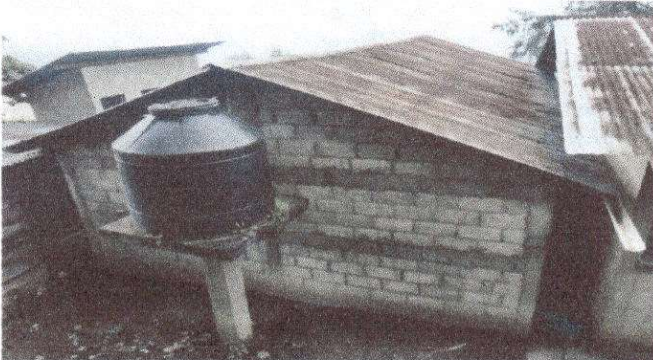
Foto 3: Sustitución de deposito 1100 litros
