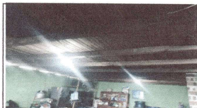
Foto 6: . Cambio de cubierta
